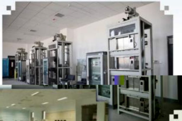
智能电梯安装调试 维护训练场所
